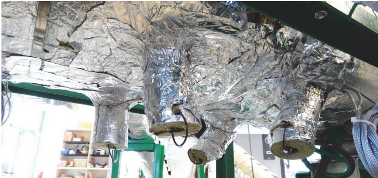
Abbildung 65: Auslass des flüssigen PCM an der Unterseite des Trogs durch vier beheizbare Rohrleitungen
